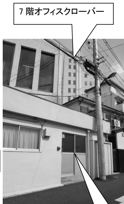
B棟1階 入口
