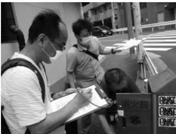
マスクをして消火器点検作業中
